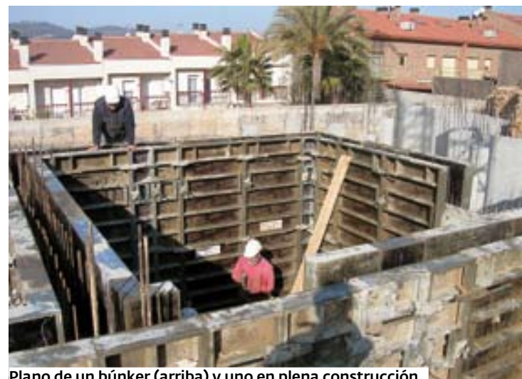
Plano de un búnker (arriba) y uno en plena construcción.
